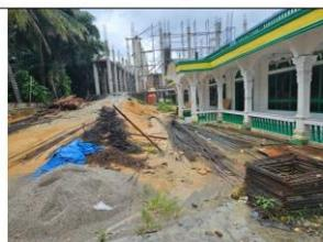
Gambar 6. Air hujan yg menggenangi dan meresap pada tanah timbun dalam bangunan masjid
