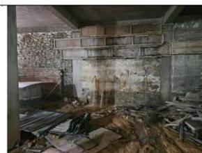
Gambar 7. Air hujan yg menggenangi dan meresap pada tanah timbun dalam bangunan masjid
